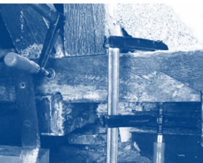
Die Restaurierung komplizierter Knotenpunkte ist eine Hauptaufgabe des Restaurators
