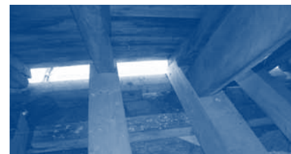
Neu eingebrachte Balkenlage
