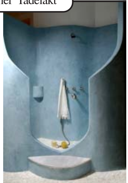
Oberflächenveredelung mit Tadelakt.
