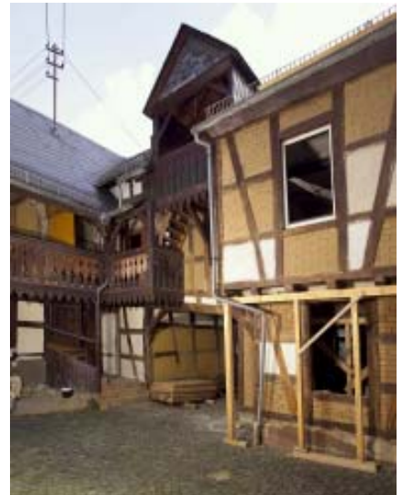
Praxisbaustelle in Herrstein
