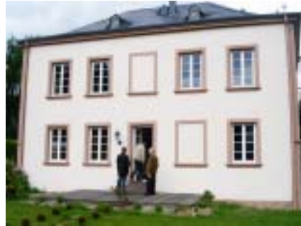
Das Burgenhaus in Saarburg nach ...
