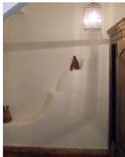
Ehemaliger Barockgiebel im Dachgeschoss.
