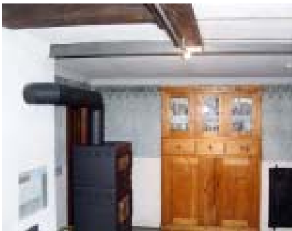
An der linken Wand erkennt man das freigelegte Farbschichtenfenster.
