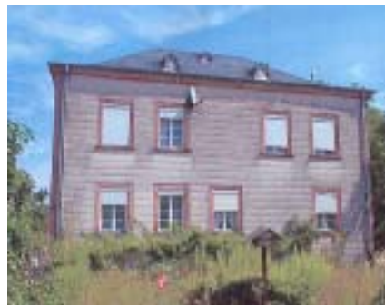
... und vor der umfangreichen Innen- und Außenrestaurierung.
