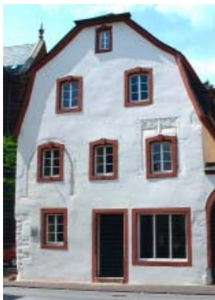
Wohnhaus Briel in Trier-Ehrang, erbaut 1593, nach der Restaurierung.
