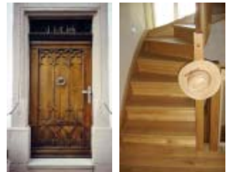
Restaurierte Eingangstür und neue Innentreppe des Hauses Kinnen.
