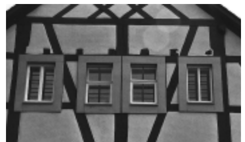
Das rechte Fenster wurde rekonstruiert.
