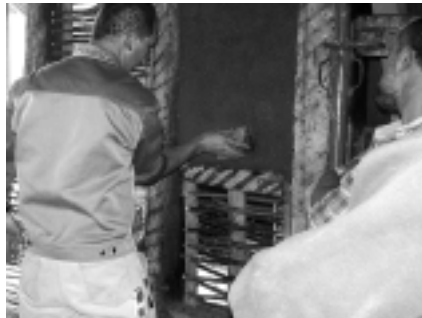
Nach dem Einzug eines Stakengeflechts werden die Gefache mit Lehm verputzt.
