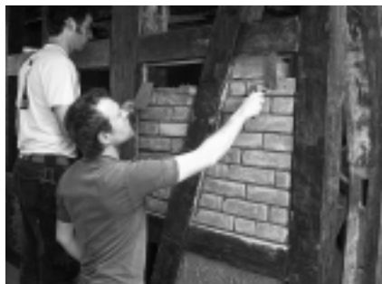
Ausmauern der Gefache mit Lehmsteinen.
