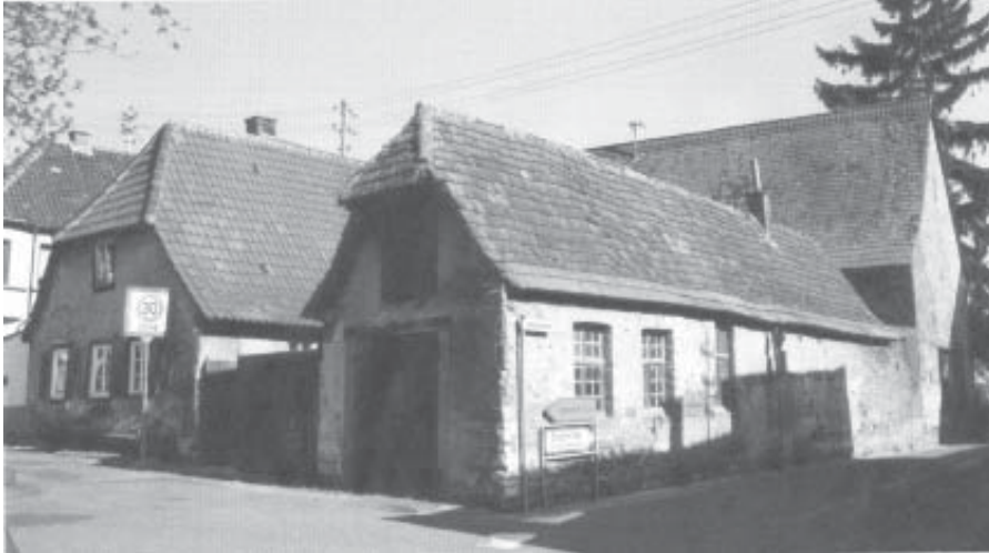
Hofanlage in Landau-Mörzheim
