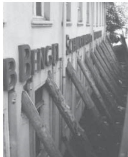
Notsicherung der Außenwand
