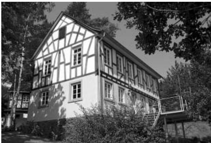
Das fertig errichtete Fachwerkhaus bei Oberwesel.
