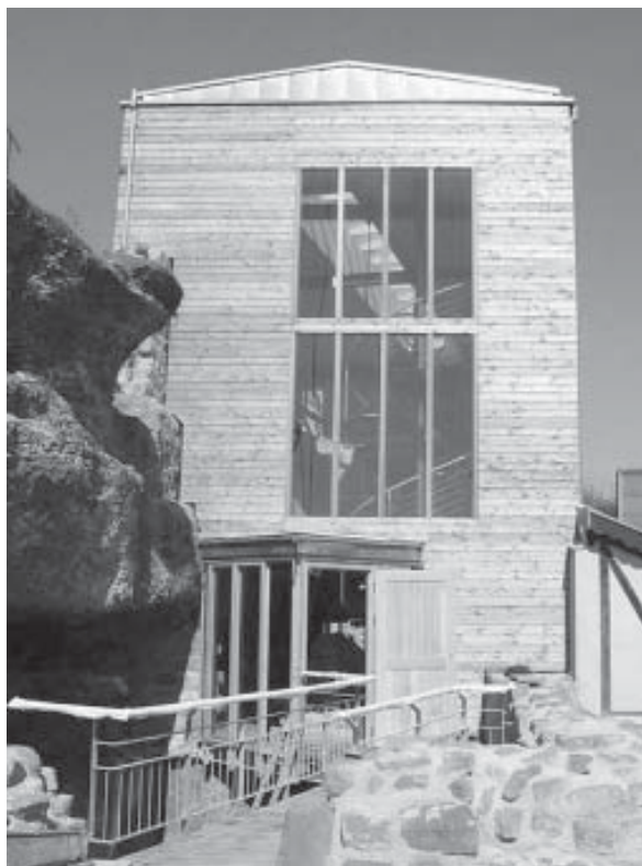
Eine Schutzhülle aus Holz und Stahl ist über die Burg Lemberg gebaut und bietet auf drei Ebenen Einblicke und Informationen in die Geschichte.
