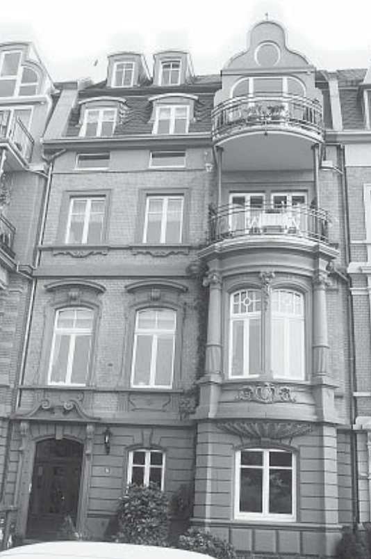
Wiederhergestellte Backsteinfassade in der Uferstraße.
