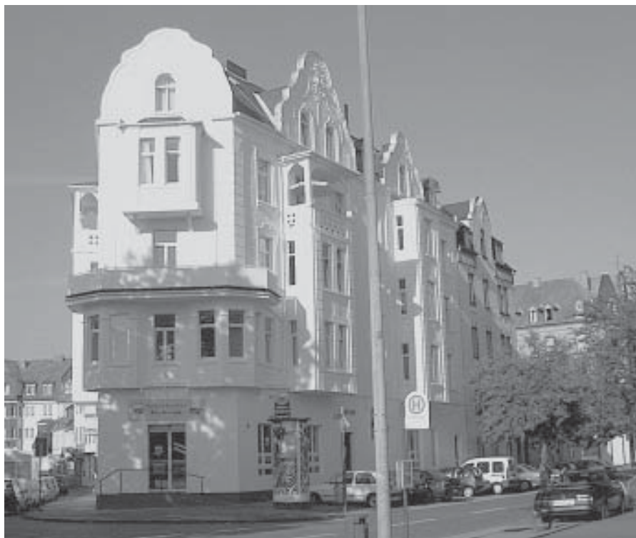
Wohnen und Arbeiten mit Blick auf die Mosel: Das 1906 gebaute Haus in der Neuendorfer Str. wurde nach 5 Jahren Leerstand jetzt wieder bezogen.
